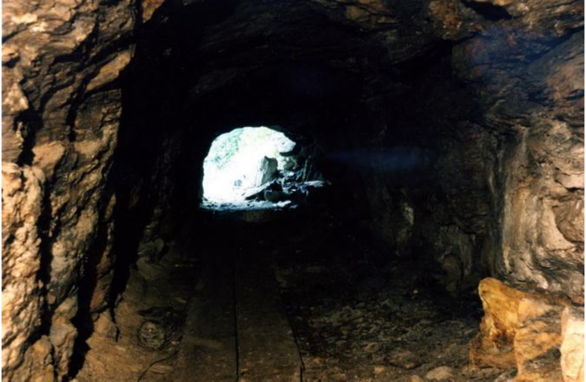
Tunnel long de 30 mètres réalisé par Albert Maret au début du XX e siècle afin d'éviter les déblaiements de cailloux.
