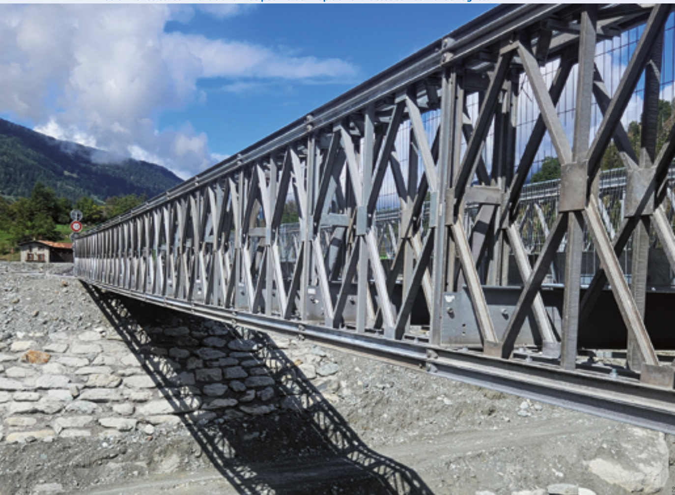
À la suite du nouvel épisode de laves torrentielles de juin 2025, un pont militaire provisoire de 51 mètres est commandé à l'armée pour rétablir rapidement l'accès au Haut val de Bagnes.
