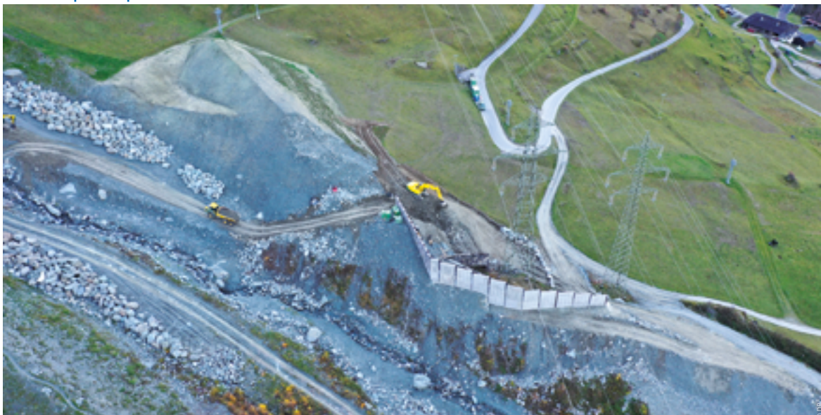
La nouvelle paroi de protection en construction.
