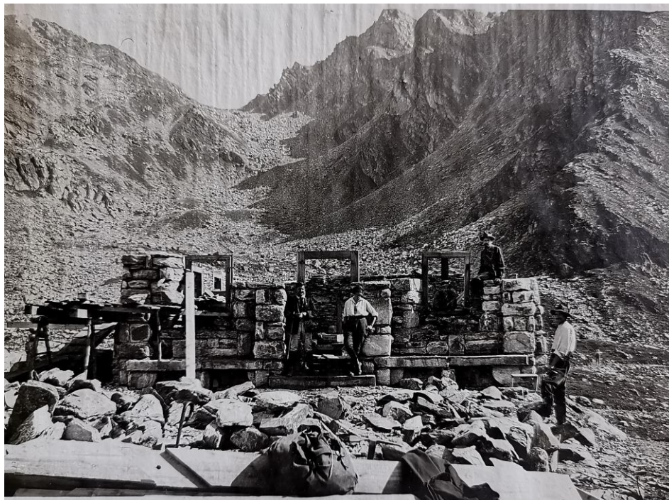
Etat des travaux le 27 juillet 1925. © Oscar Nicollier (Fonds privé de la Famille Besse)
