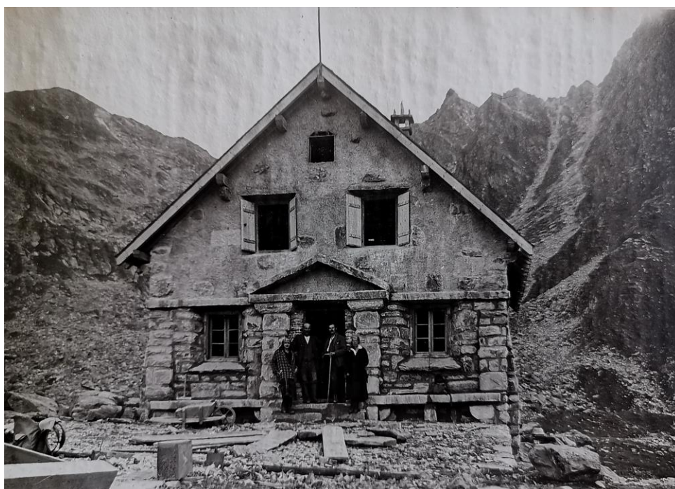
Etat des travaux le 22 août 1925, un mois avant l'inauguration. © Oscar Nicollier (Fonds privé de la Famille Besse)
