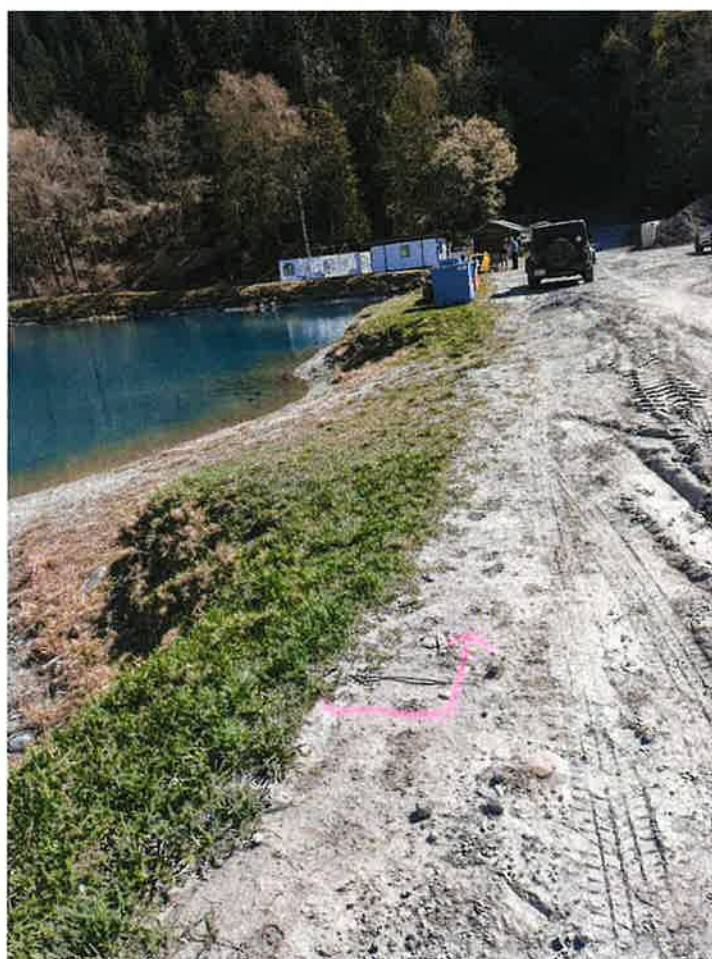
Figure 2 : Vision sur site (P de la fig. 1). La bande terreuse correspond à l'espace dédiée aux usagers. La flèche étant la délimitation et la bande sableuse correspond au passage utilisé par les machines de l'exploitation.
