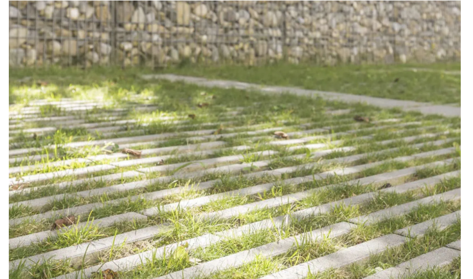
Places de stationnement en pavés-gazon : infiltration des eaux, aspect esthétique
